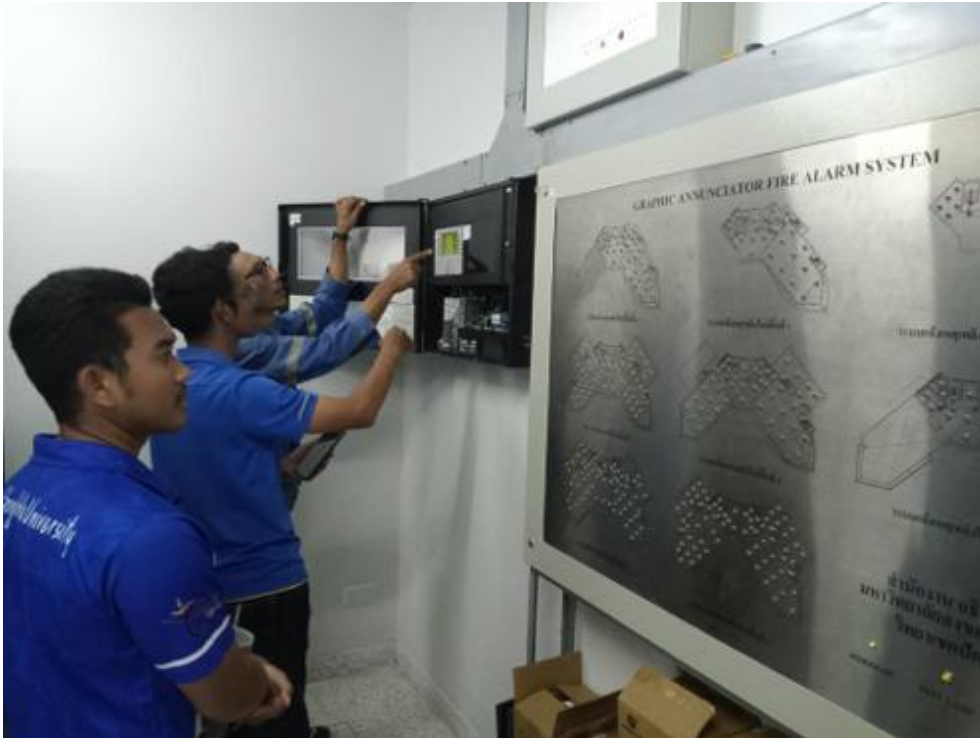
ตรวจสอบ/ซ่อมแซมระบบสัญญาณแจ้งเตือน
