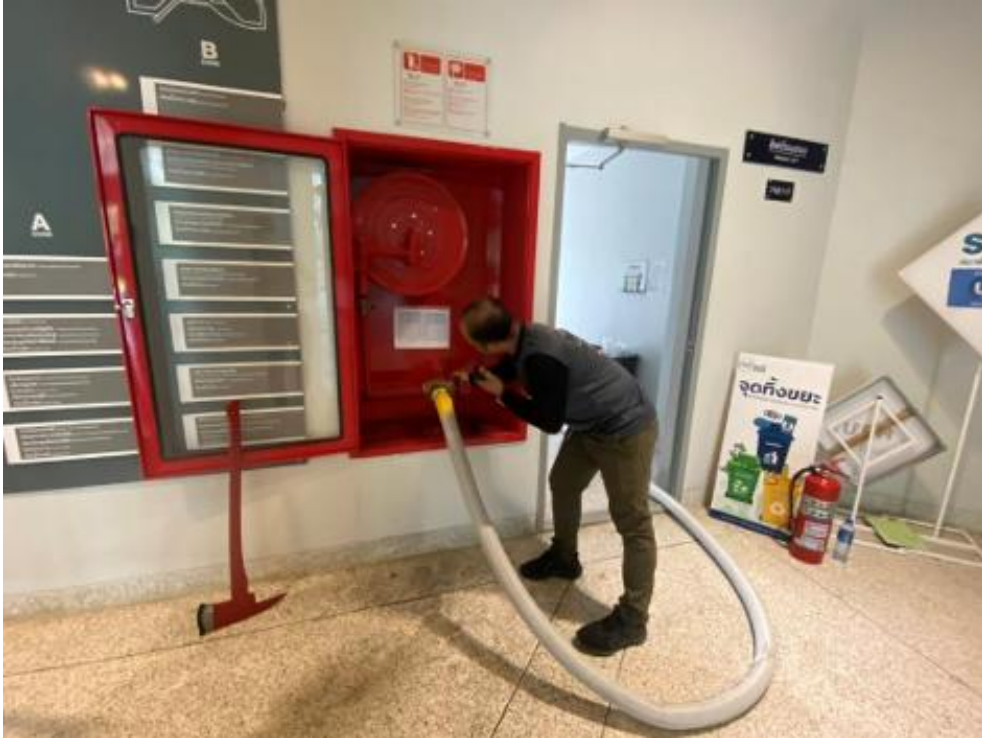
ตรวจสอบและบำรุงระบบฉีดน้ำดับเพลิง
