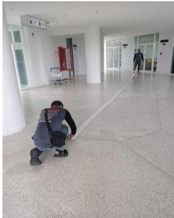
การตรวจสอบสายฉีดน้ำดับเพลิง
