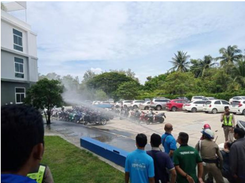
ทดสอบระบบฉีดน้ำดับเพลิง
